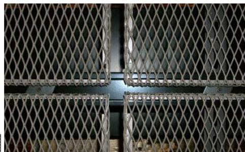
Bei Vordächern im Außenbereich werden die Einhängewinkel und Sicherungsbleche anstatt aus verzinkten Stahlblech aus hochwertigen Aluminium hergestellt und die Rostwinkel und Noniushänger mit Korrosionsschutzlack der Qualität C4 versehen
